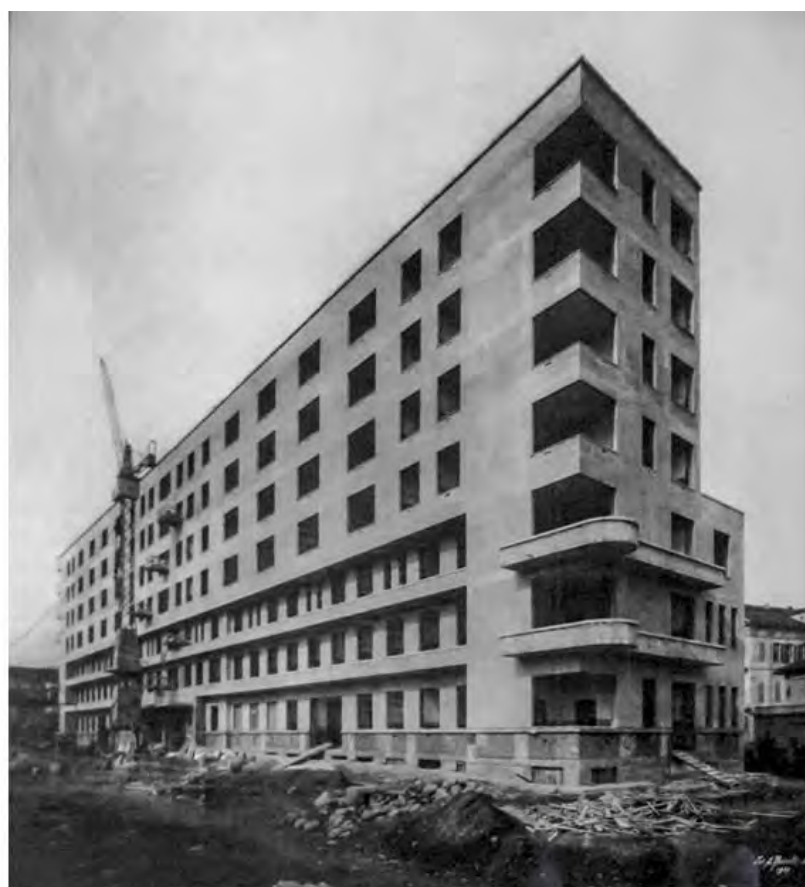
OSPEDALE DEGLI INFERMI MONOBLOCCO. FACCIATA A BASSOGGIOINO - BIELLA - PROGETTATA ING. DI GIULIO MARCOVIGI
